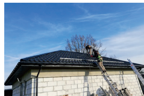
Budowa instalacji odnawialnych źródeł energii
