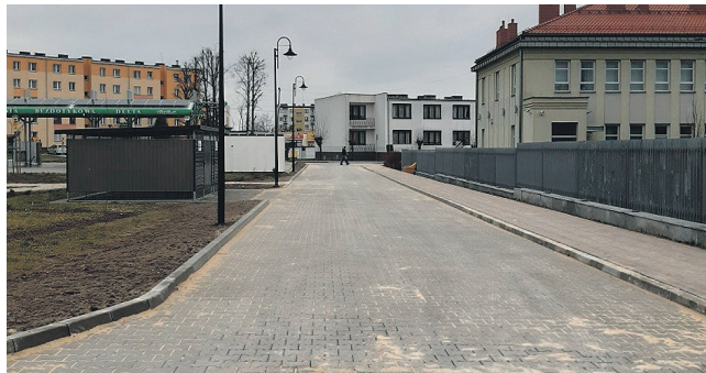
Nowa droga i wiata śmietnikowa na osiedlu Armii Krajowej
