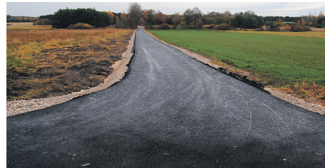
Nieznanowice - nowa droga
