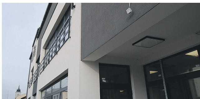
Postępuje rewitalizacja budynku przy ul. Pocztovej
