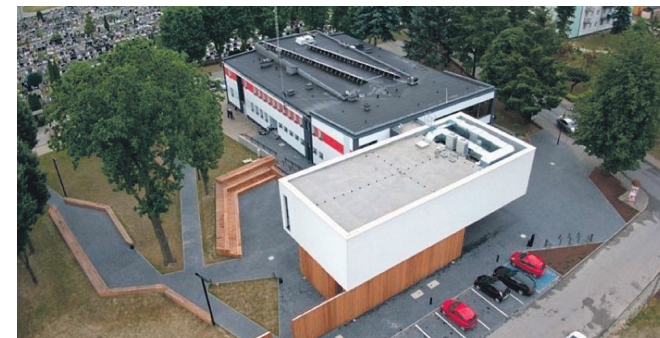
Dom Kultury po modernizacji
