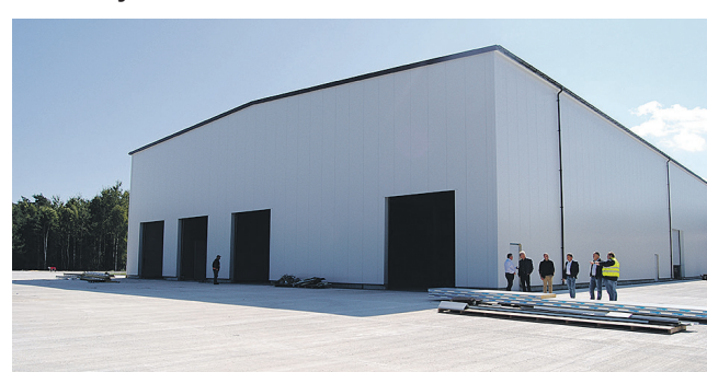
Budowa hali przetwarzania odpadów.
