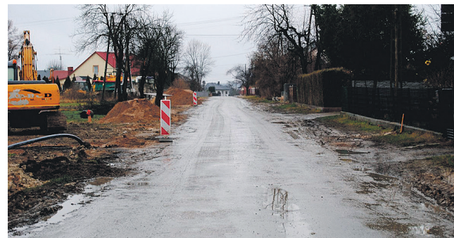
Budowa kanalizacji w Koniecznie
