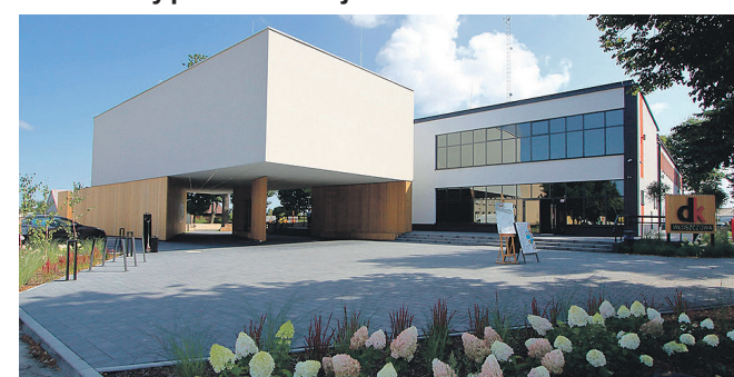
Dom Kultury po modernizacji
