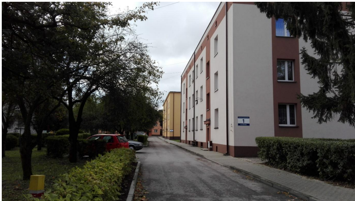
Rysunek 14 Osiedle Brożka (zabudowa mieszkalna)
