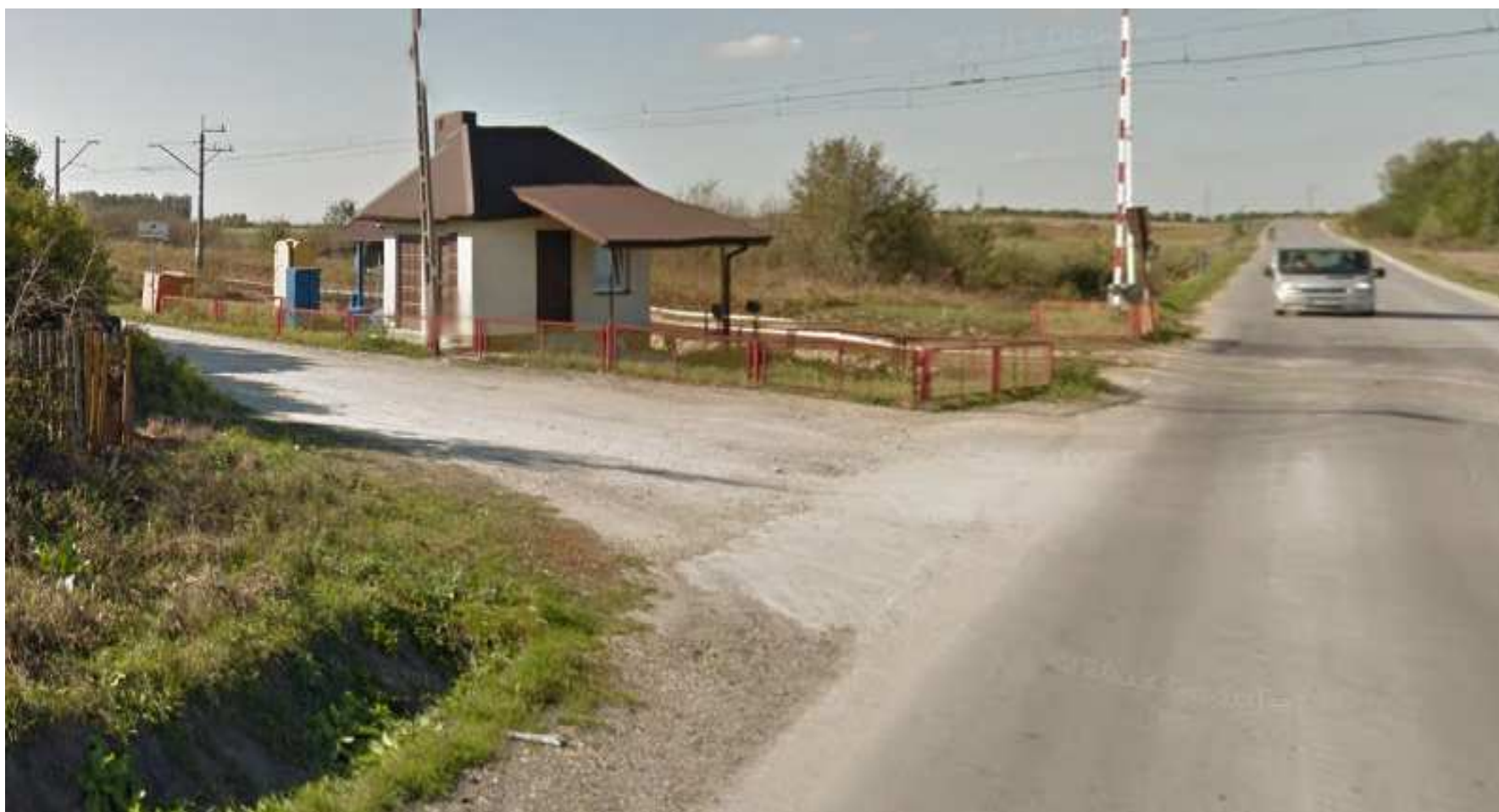
Wola Wiśniowa – (połączenie istniejącej nawierzchni asfaltowej z odcinkiem szutrowym planowanym do remontu)
