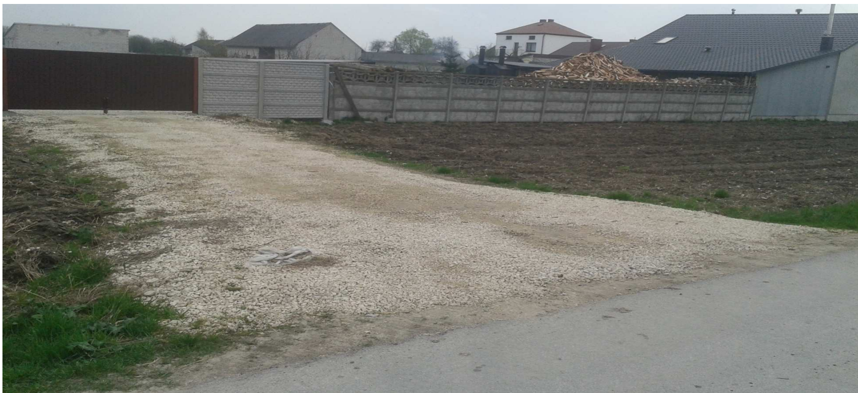
Planowana do remontu droga wewnętrzna w Woli Wiśniowej
